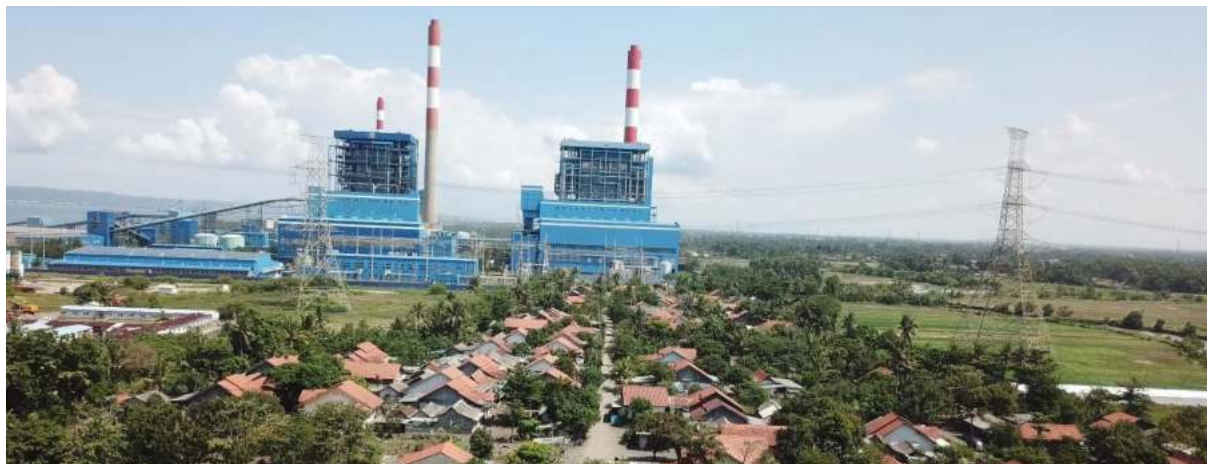
Ring 1 PLTU Karangandri, Kabupaten Cilacap, Jawa Tengah. Foto: Dokumentasi CELIOS 2023
